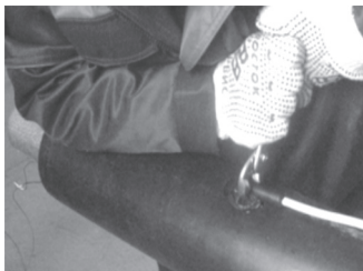
Рис. 4 Изделие «СКВ» вваривается в оболочку трубы
