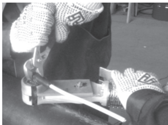
Рис. 3 Изделие «СКВ» разогревается в «насадке сварочной»
